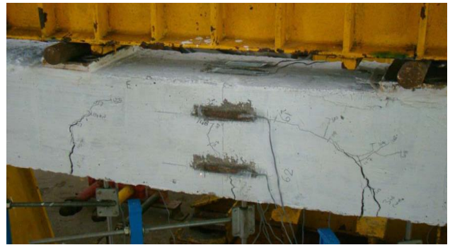
(d) final cracking at ultimate load
